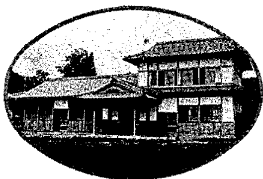
写464 榎田村役場（旧榎田支所・市内大字田能） （「ふるさとの風土・高槻」より）
