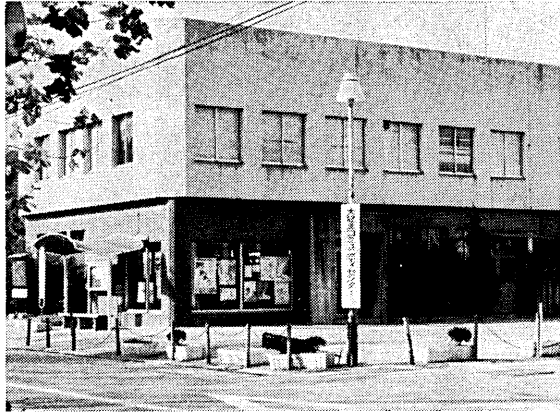
写516 大冠北コミュニティセンター（市内永楽町）
